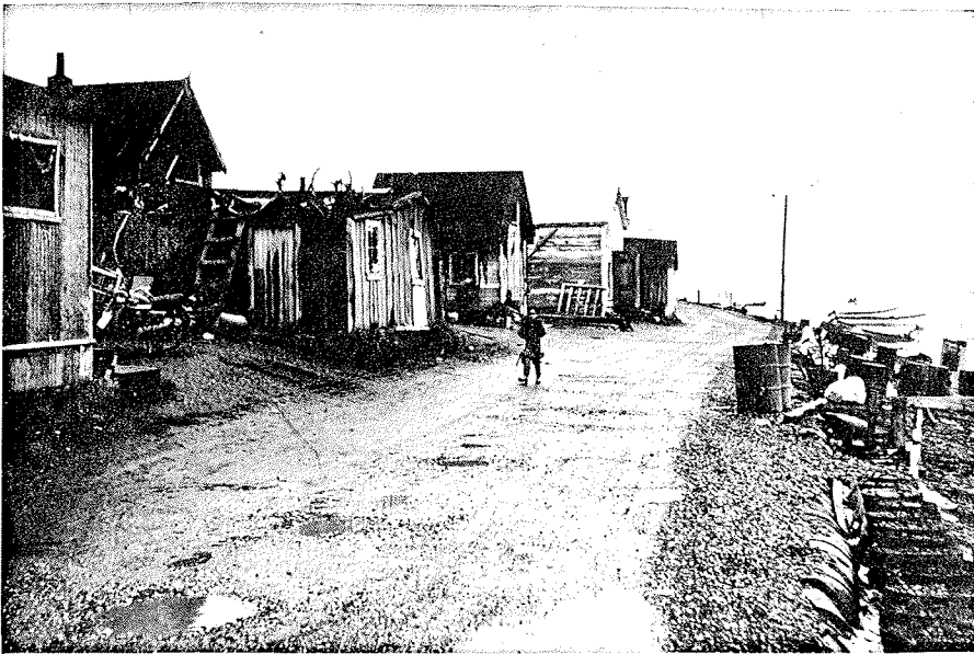
Abb. 7: Ungenügende Wohngebäudesubstanz in Kotzebue, 1973. Fig. 7: Substandard Eskimo housing in Kotzebue, 1973.
