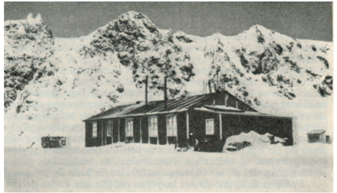
Abb. 1: Das Stationsgebäude der „Base Orcadas“ um 1950 aus MONETA (1954).
