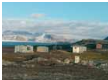
Das 5 km von Ny-Ålesund entfernt liegende Reinluftobservatorium, benannt nach dem französischen Polarforscher Jean Corbel, ist mit wissenschaftlichen Instrumenten zur Beobachtung des lokalen Wettergeschehens und zur Spurenstoffanalyse ausgerüstet. Solarzellen decken einen Teil des Energiebedarfs. (Foto: Franck Delbart)
