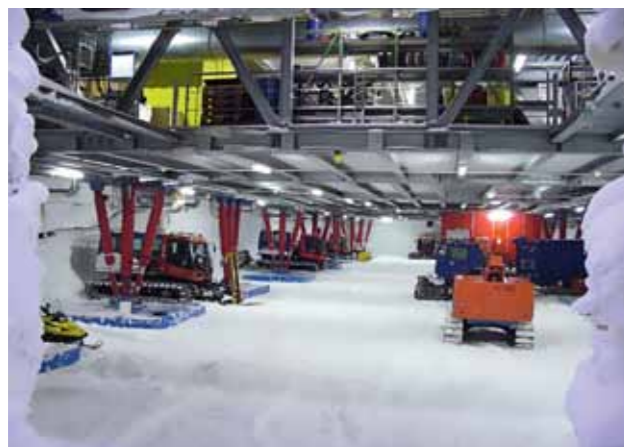
Abb. 7: ‚Neumayer-Station III‘ – untere Stahlkonstruktion und hydraulische Stützen in der Garage
