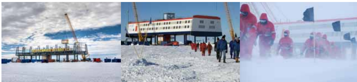
Abb. 2: Baufortschritt in der Saison 2008/2009
