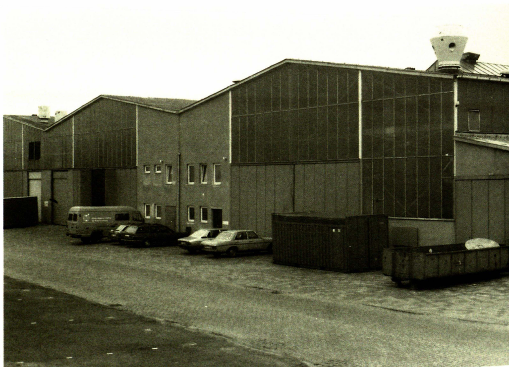
Die neue Lagerhalle des AWI im Freihafen wurde im Juni 1987 in Betrieb genommen. (Foto: Norbert Müller)
