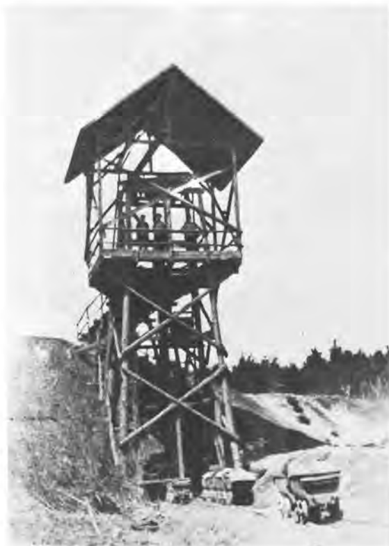
Abb. 7. Wasserkastenaufzug der Grube Aussicht, Wald-Michelbach (Foto aus KÖBRICH 1928).
