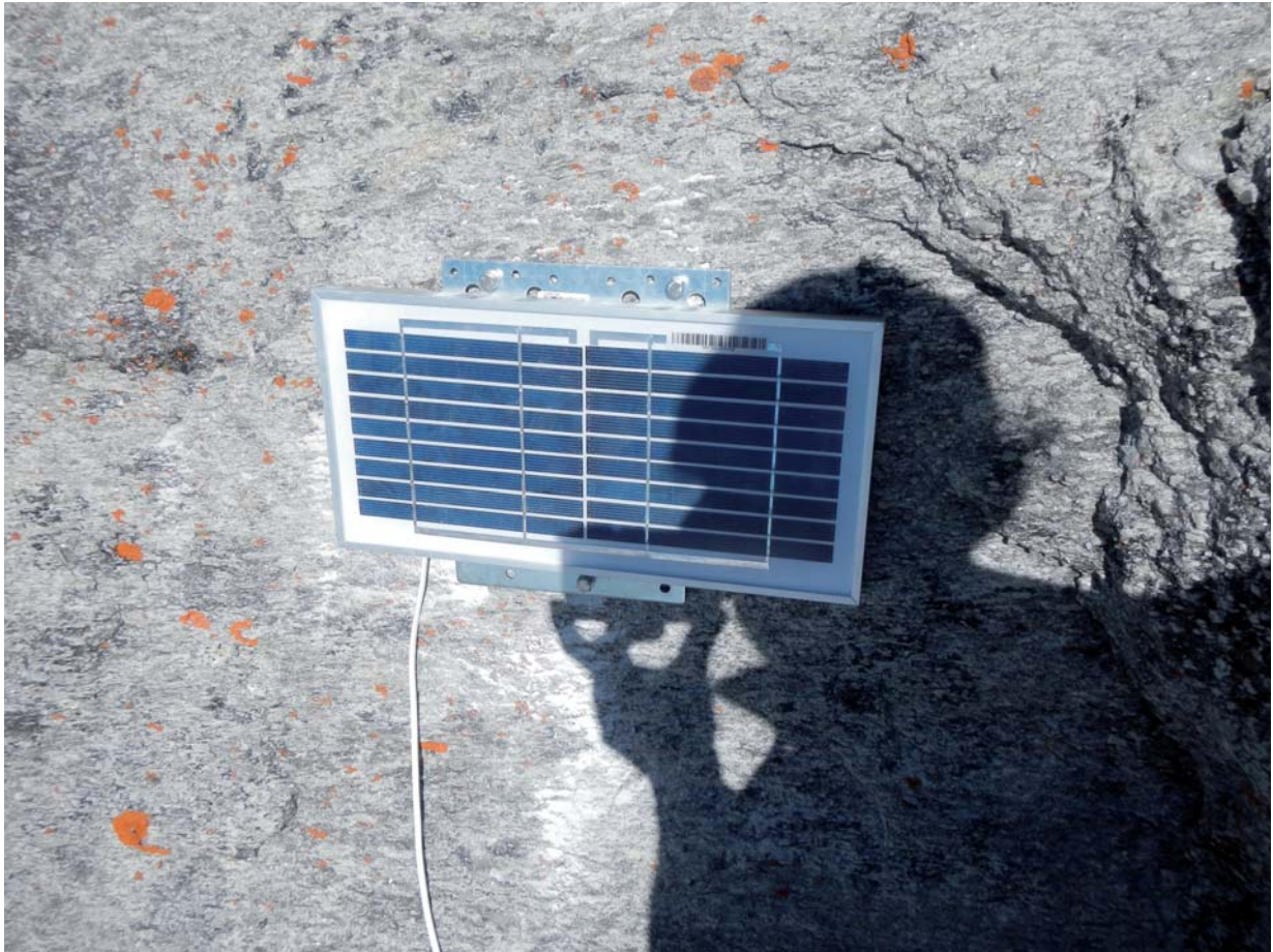
Abbildung A.4: Neue Montage der Solarpanele.
