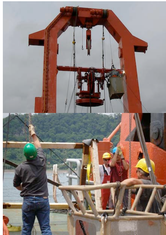
Fahrt- und stellvertretender Fahrtleiter trainieren (unten). Schweißarbeiten am A-Rahmen (oben).
