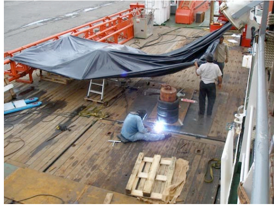
Verschweißen von Stahlplatten für das Fundament der Winde
