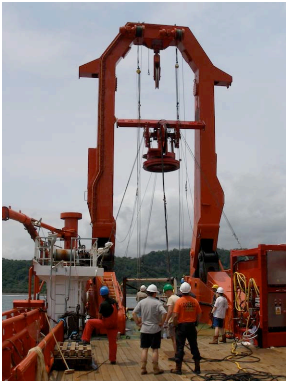
Einpassen der 4,5t schweren Aussetzvorrichtung in den A-Rahmen.
