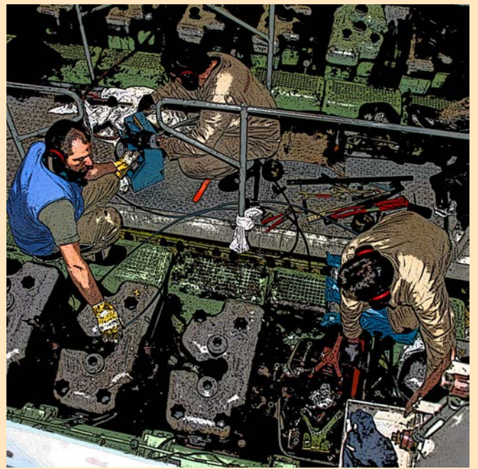
zügige reparatur einer hauptmaschine
