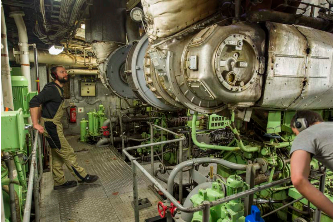
2 - Der Chief und seine Maschinen. Auf zahlreichen interessanten Führungen hat er uns die komplexe, solide und auch nach 33 Jahren einwandfrei funktionierende Antriebstechnik des Schiffes erklärt. Foto: AWI.
