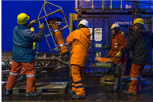
Verankerungsarbeiten (Foto: Christian R. Rohleder)
