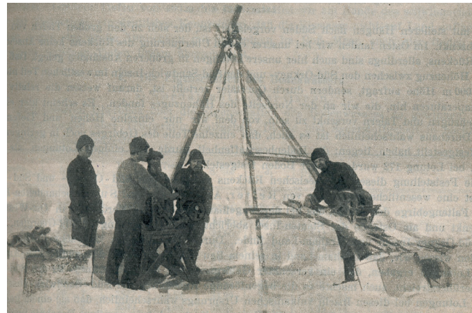
Abb 17: Lotung der Meerestiefe und Entnahme von Wasserproben mit einer kleinen Lucas-Maschine weit vom Schiff entfernt auf dem Meereis (BRENNNECKE 1921 S. 31).
