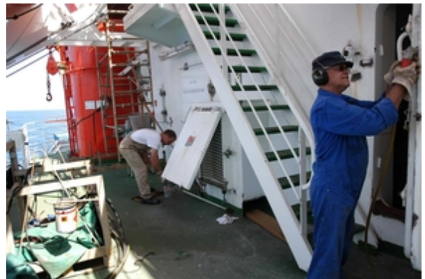
Erhaltungsarbeiten auf Polarstern. Foto: S. El Nagggar
