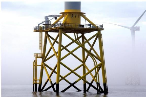
Abb. 17: Jacketkonstruktion bei Niedrigwasser, Aufnahme datum 12.04.2012 - 08.29 Uhr
