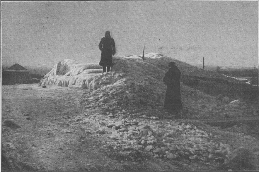
Abb. 60. Taryneisbildung bei den Wohnhäusern der Eisenbahnstation Uruscha (54° N, 123° O).
